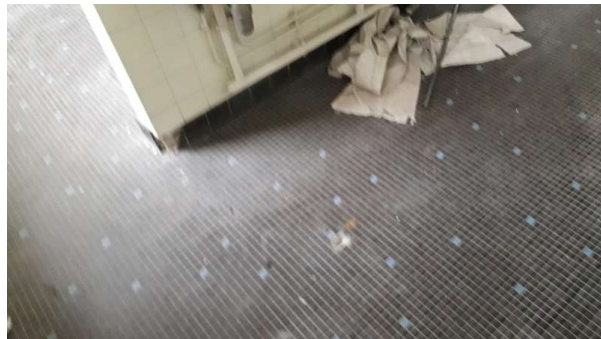
Prélèvement - P17 : R+1 / 01.010 - Colle de carrelage- (Absence d'amiante)
