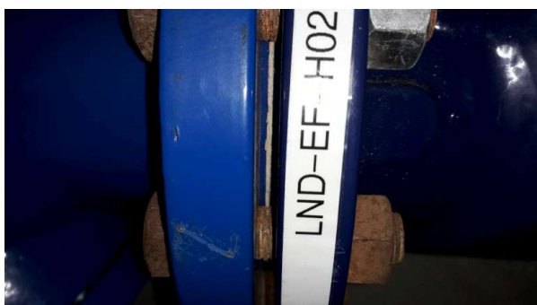
Prélèvement - P63 : R-1 / OS1.17 - Joint de bride- (Absence d'amiante)
