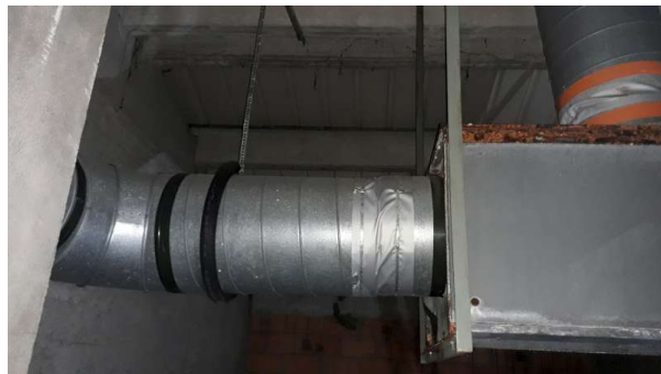
Prélèvement - P7 : R+2 / 02.004 - Soufflet- (Absence d'amiante)
