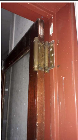
Déclaré - : R+1 / 01.024 - Joint de porte- (Absence d'amiante)
