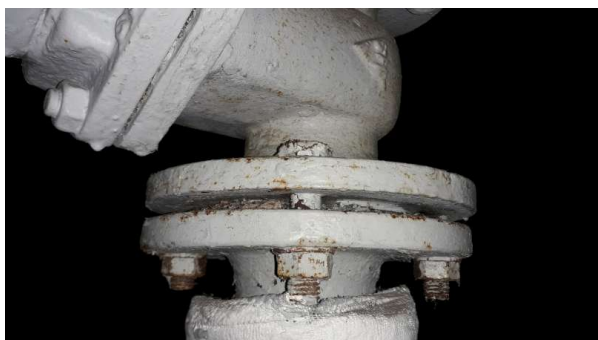
Prélèvement - P52 : R-1 / OS1.03 - Joint de bride- (Présence d'amiante)
