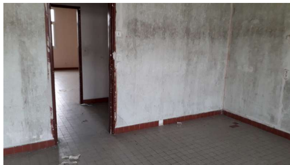
Prélèvement - P12 : R+1 / 01.009 - Colle de plinthe- (Présence d'amiante)
