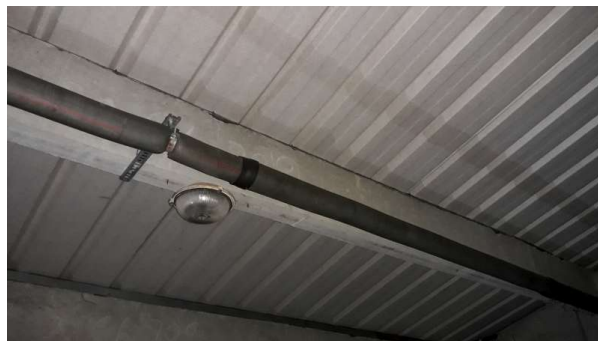
Déclaré - : R+2 / 02.001 - Calorifuge coquille- (Absence d'amiante)
