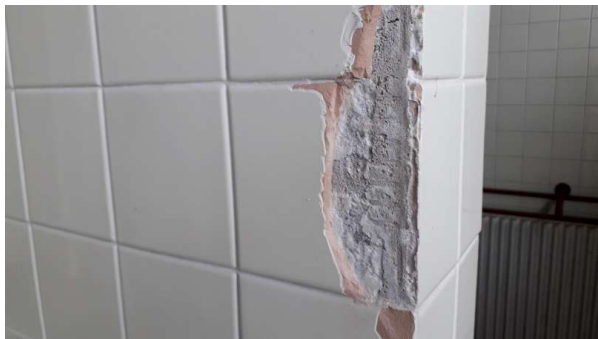
Prélèvement - P19 : R+1 / 01.010 - Colle de faïence- (Absence d'amiante)
