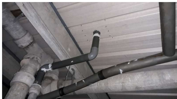
Prélèvement - P4 : R+2 / 02.001 - Mastic- (Absence d'amiante)
