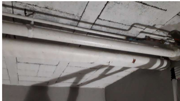
Prélèvement - P46 : R-1 / OS1.15 - Enveloppe de calorifugeage - (Absence d'amiante)
