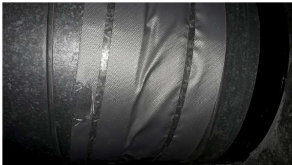
Prélèvement - P7 : R+2 / 02.004 - Soufflet- (Absence d'amiante)
