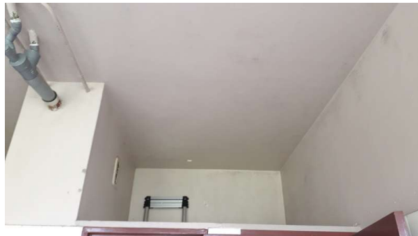
Prélèvement - P39 : R+0 / 00.021 - Peinture- (Présence d'amiante)
