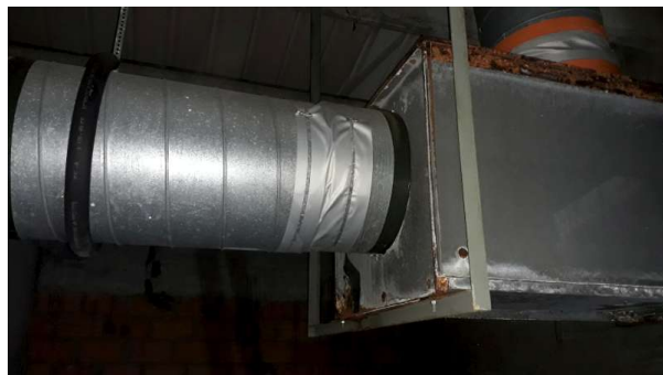
Prélèvement - P6 : R+2 / 02.004 - Mastic- (Absence d'amiante)
