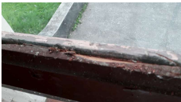
Prélèvement - P65 : R+0 / 00.019 - Mastic- (Absence d'amiante)
