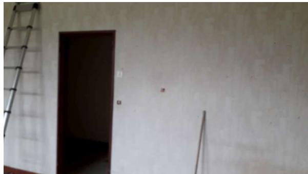
Prélèvement - P30 : R+0 / 00.020 - Revêtement- (Absence d'amiante)
