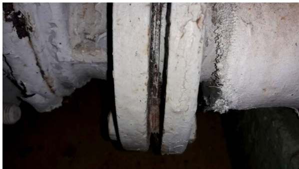
Prélèvement - P51 : R-1 / OS1.03 - Joint de bride- (Présence d'amiante)
