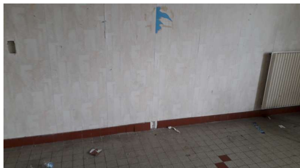
Prélèvement - P29 : R+0 / 00.020 - Colle de plinthe- (Présence d'amiante)
